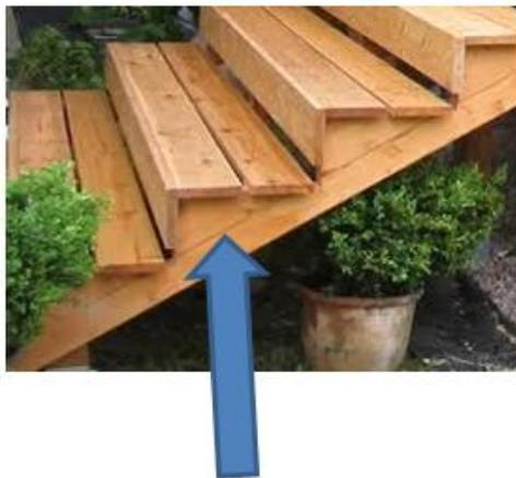
Тетива – это основа лестницы, несущая опорная конструкция, в виде наклонной балки.
